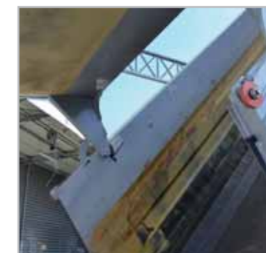
Bras de porte encastrés, poulie de renvoi de bâche à l'arrière de la caisse.
